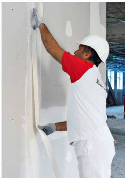
(2) Incollaggio e posa della cinta
