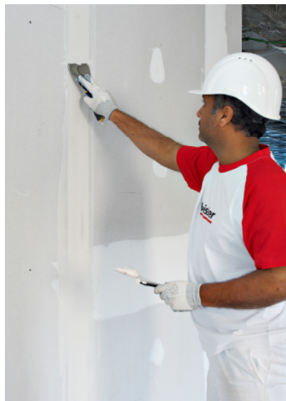
(1) Riempimento della fuga
